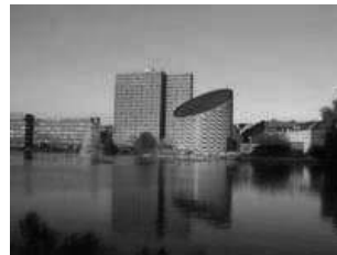
Figura 18.3: Elipse no telhado do planetário Tycho Brahe em Copenhaga, Dinamarca.
